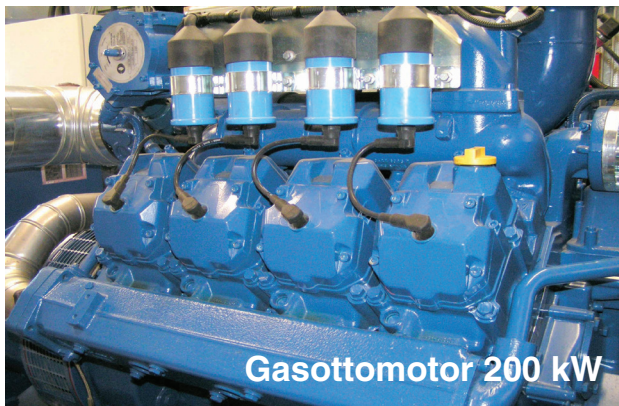
Bild 5. Större biogasanläggningar använder oftast stora ottomotorer vid generering av elektricitet
