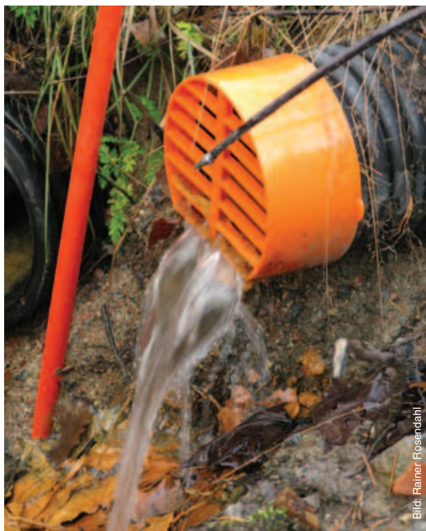
Bild 1. Dräneringsutloppet ska hållas fritt från slam och rötter.
