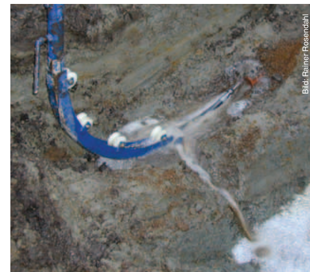
Bild 5. Spolning av täckdiken.
