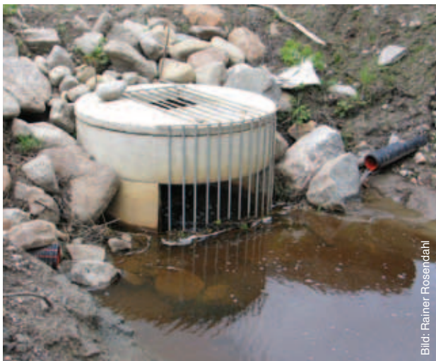
Bild 3. Kolla rissel och nackdikesbrunnar våår och höst.
