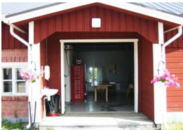
↑ I en äldre, liten ladugård har man byggt ett förpackningsutrymme för bär. I förpackningsutrymmet finns ett kylrum och utanför ett handtvättningsställe.
