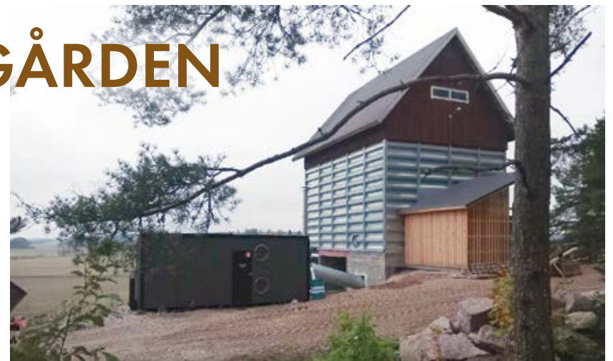
Spannmålstorkning med en containermonterad fliseldad hetluftspanna.
